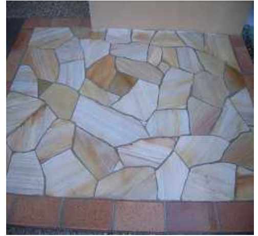
門柱前は目を引く自然石の乱張り
